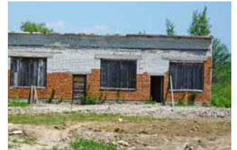
Das renovationsbedürftige Werkstattgebäude
