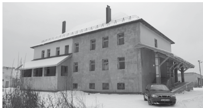
Die Aussenarbeiten am Hauptgebäude sind bald abgeschlossen.
